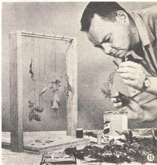
Gli oggetti non metallici, come queste foglie, possono essere placcate. Il segreto sta nel rendere la loro superficie conduttrice di elettricità spalmandola con una vernice metallica, come spiegato nel testo, od anche preparando da voi un composto di polvere di bronzo, esente da grassi, con un po' di vernice di spato allungata.
